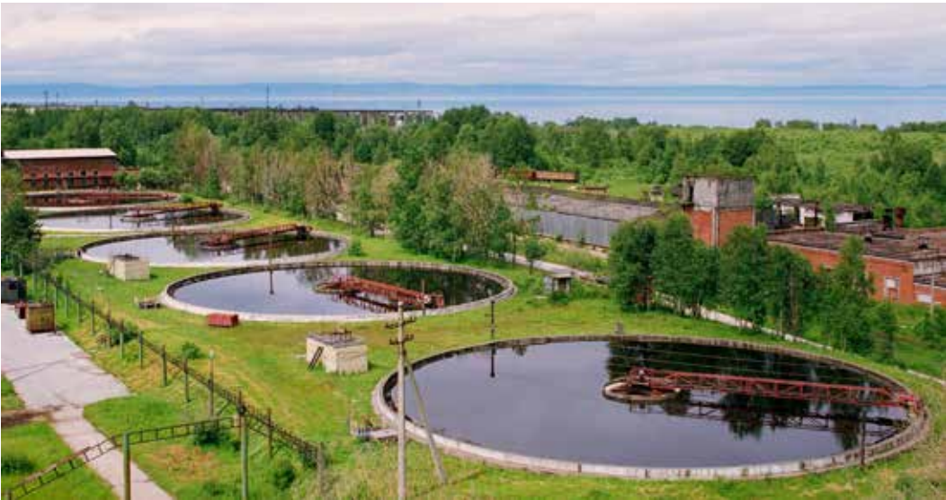
Байкальский целлюлозно-бумажный комбинат. Часть очистных сооружений
